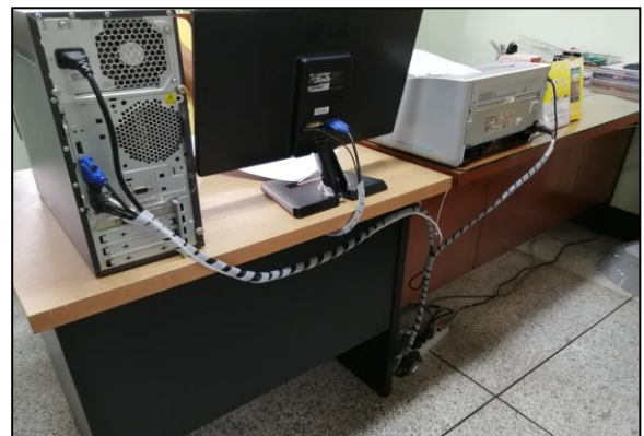
การจัดเก็บสายไฟคอมพิวเตอร์
